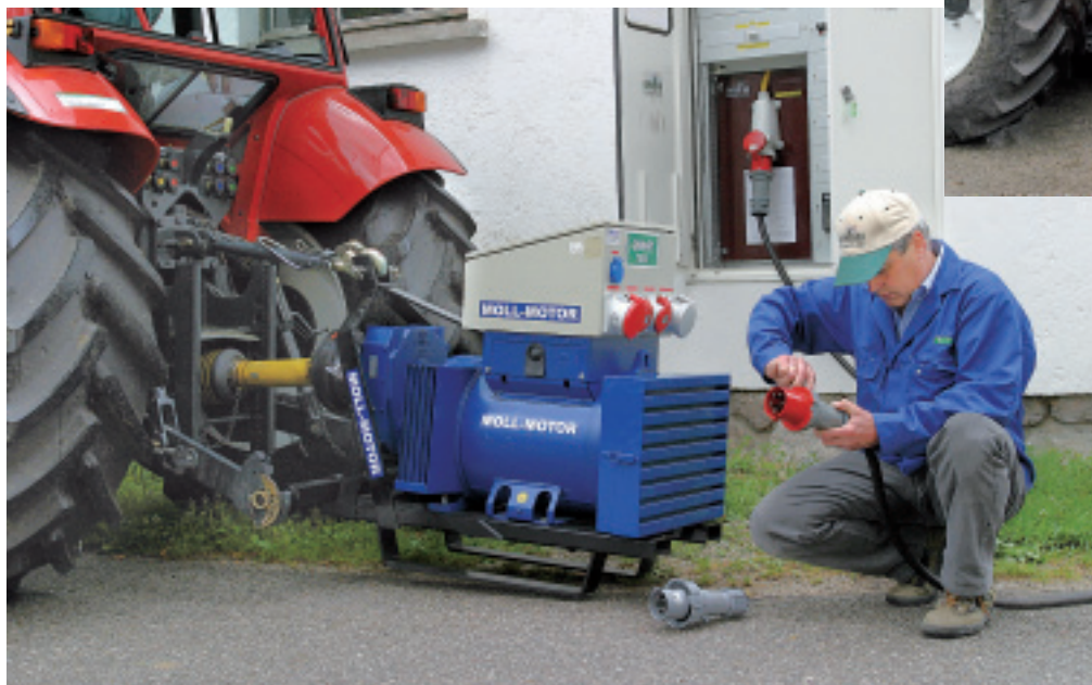
Vorbereitungsarbeiten eines Elektrofachmannes für den Probebetrieb.
