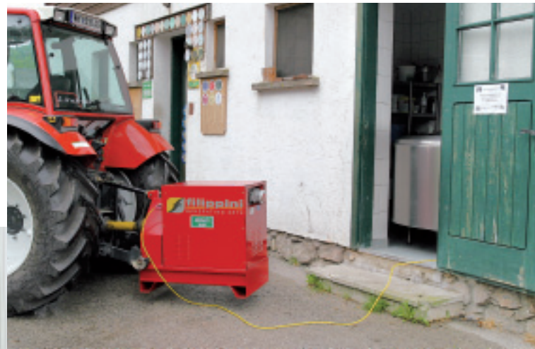
▲ Direktversorgung einer Milchkühlanlage.
