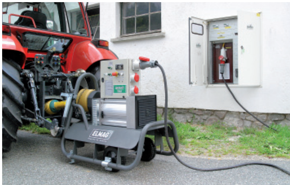
▲ Generator mit Notstromspeiseinstelle.
